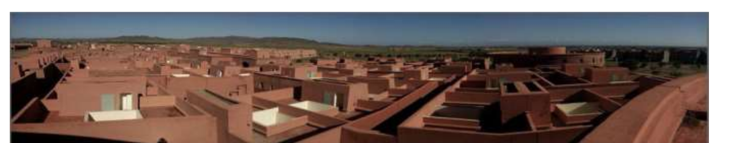
Vue d'un roof top sur la ville de Tamansourt
