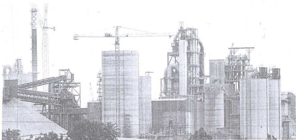
● La nouvelle cimenterie de Lafarge à Taroudant, qui sera mise en service au cours du 1 er semestre 2016, s'étalera sur une superficie de 150 ha.
