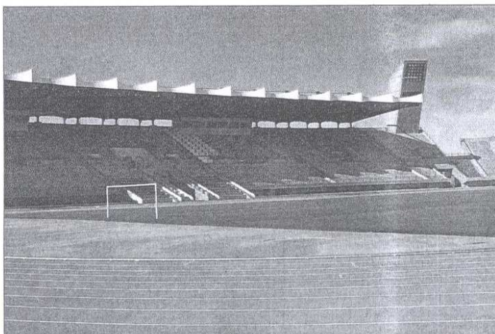
L'objectif du programme de mise à niveau des infrastructures est d'asseoir une base solide pour la pratique du football, permettant de faire éclore les compétences dans les petites villes et les quartiers populaires (Ph. Archives de L'Economiste)
