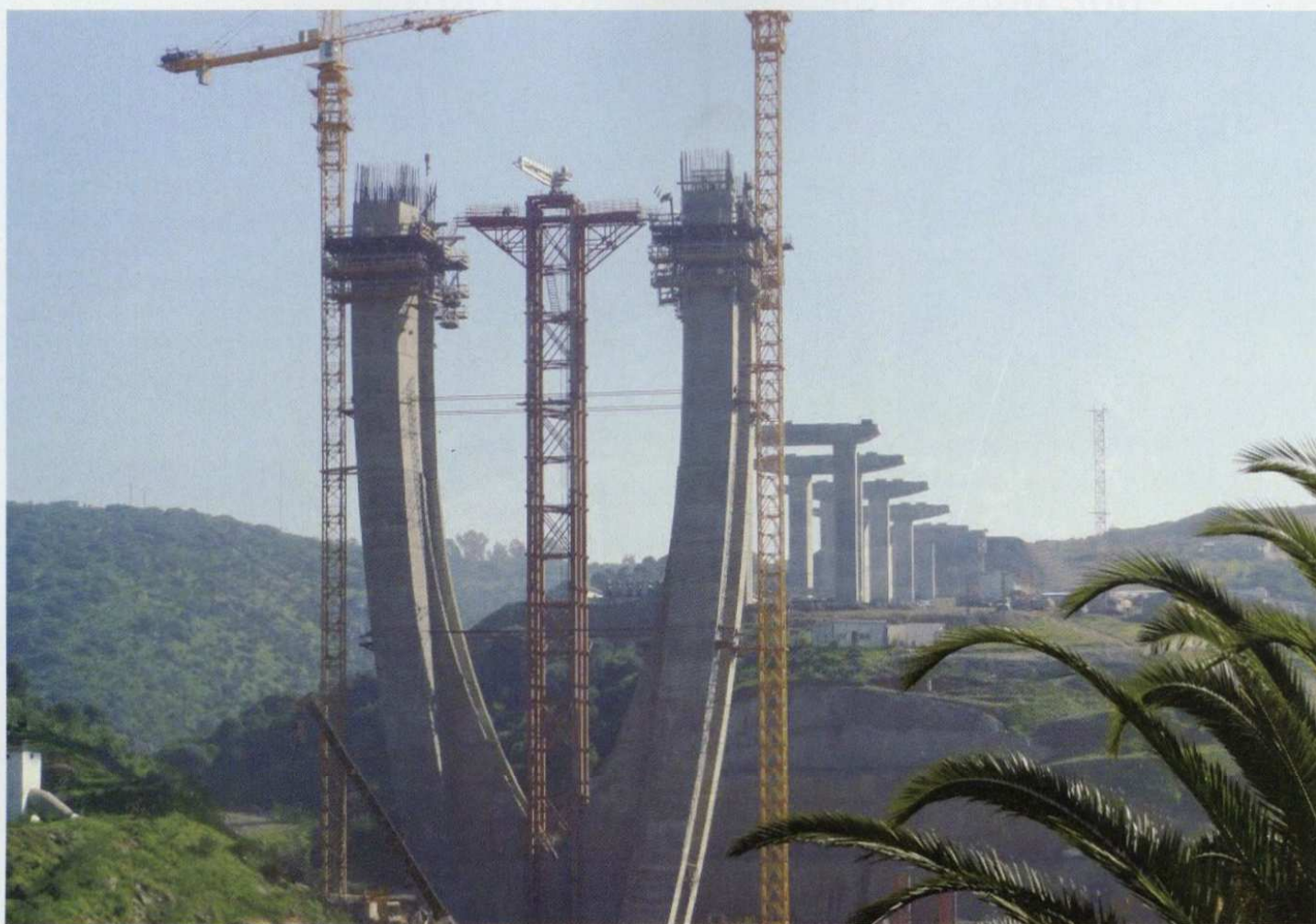
Modèle Le Pont à haubans sur l'oued Bouregreg est financé conjointement par la BEI et les fonds propres de l'ADM.
