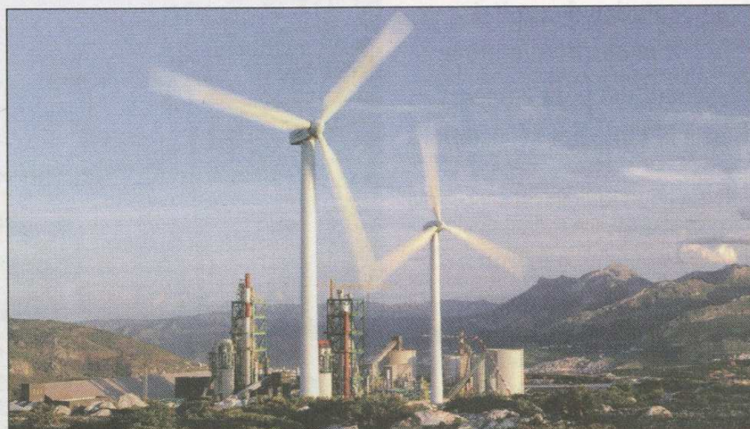
A l'instar de l'usine de Lafarge Maroc à Tétouan alimentée en électricité d'origine éolienne, le segment de l'auto-production privée d'origine éolienne a déjà pris son envol (Ph. Lafarge Maroc)
