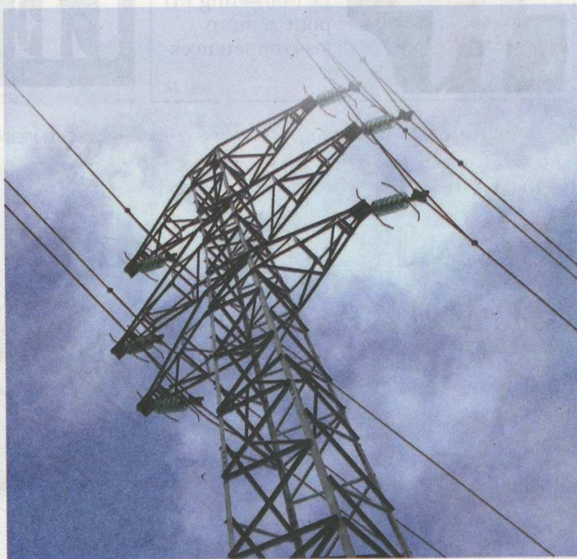
Le plan d'équipement de l'ONEE prévoit la réalisation d'une capacité additionnelle de 3.765 MW entre 2015 et 2018.
