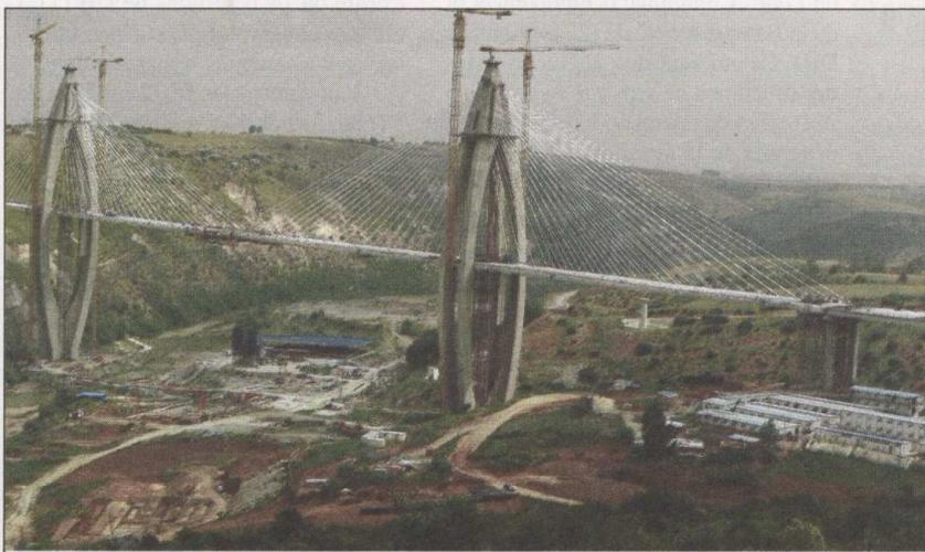
Le pont à haubans de Sidi Maârouf est le 2e ouvrage de ce type après celui du Bouregreg (sur la photo ci-dessus). Il tire son nom de l'assemblage des câbles en acier destinés à soutenir l'ouvrage et à répartir les forces (Ph. L'Economiste)
