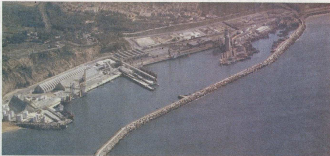
La première, dont les travaux d'aménagement sont programmés pour cette année, consiste en la réalisation d'une digue principale d'une longueur de 2.660 mètres linéaires (ml) et d'une autre, secondaire, d'une longueur de 765 ml.
