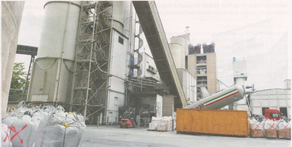
Créée il y a un siècle, la cimenterie d'Ennigerloh en Allemagne utilise une large gamme de combustibles alternatifs (RDF, boues de STEP, farines animales, pneus entiers usés, etc.) et atteint actuellement 62% de taux de substitution thermique dont la moitié provient des RDF (Ph. YSA)
