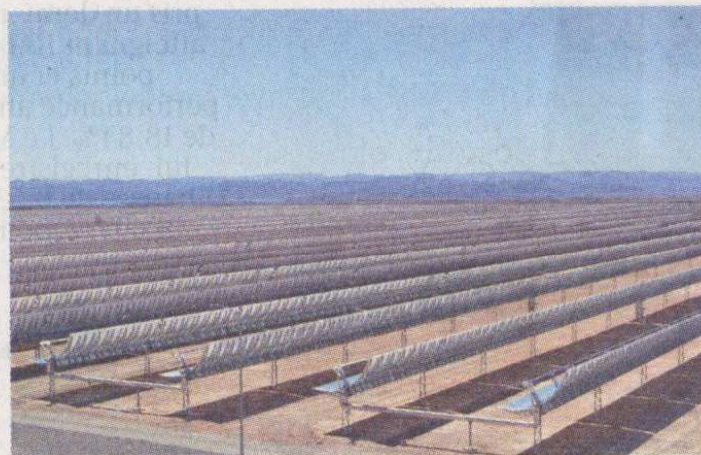
Cette première phase couvrira deux centrales hybrides PV (photovoltaïque) et CSP (solaire à concentration) avec stockage de 5 heures au minimum. Ph. Saouri
