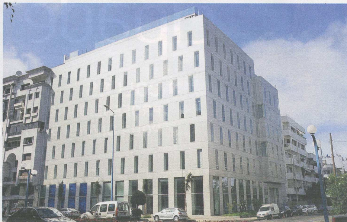
Le siège de Zurich Assurances Maroc, situé sur le bd Zerktouni, est un modèle d'efficacité énergétique et de développement durable (Ph. L'Économiste)
