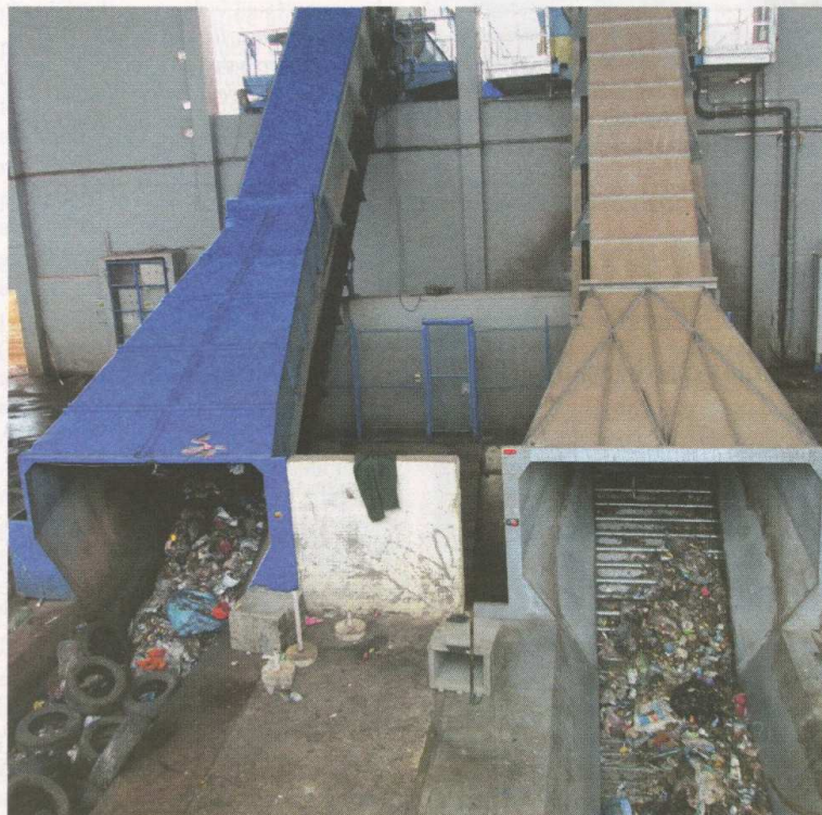
La mise en service de cette deuxième ligne de tri va renforcer la capacité de valorisation des déchets au niveau de la décharge contrôlée Oum Azza (Ph. N.E.A.)
