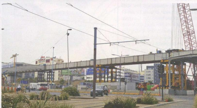
Après le montage de la structure métallique et du pylône central, le pont sera couvert par des dalles en béton et du bitume (Ph. F. Al Nasser)
