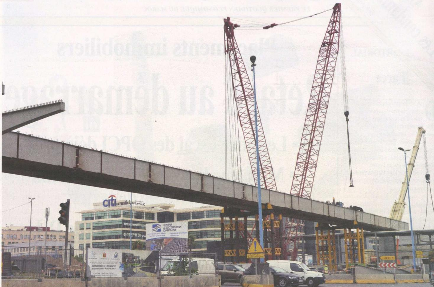
Le dernier tronçon du tablier (la partie reliant les deux culées ou extrémités du pont) sera installé cette semaine. Le pont à haubans de Sidi Maârouf est long de 224 m (Ph. F. Al Nasser)
