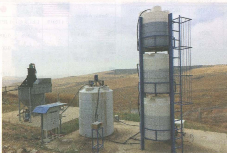
Un laboratoire de recherche de la faculté des Sciences de Dhar El Mehraz a mis en place un procédé innovant pour le traitement des lixiviats de la décharge contrôlée de la ville de Fès. Doté d'une capacité de traitement de 10m3 de lixiviats par jour, ce système a montré des résultats très prometteurs (Ph. YSA)
