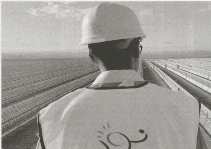
La phase I de Noor-Midelt, en cours d'adjudication, portera sur 825 MW : 300 MW en CSP et 525 en PV, sur la base deux centrales de technologie hybride.
