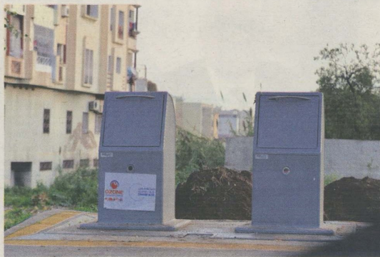
Flambant neufs, des nouveaux bacs à ordures enterrés entreront en service incessamment. Installés au niveau de la route d'Imouzzer, quartier Atlas, Bab Boujloud et dans d'autres quartiers, ces équipements sont qualifiés «d'amis de l'environnement» (Ph. YSA)
