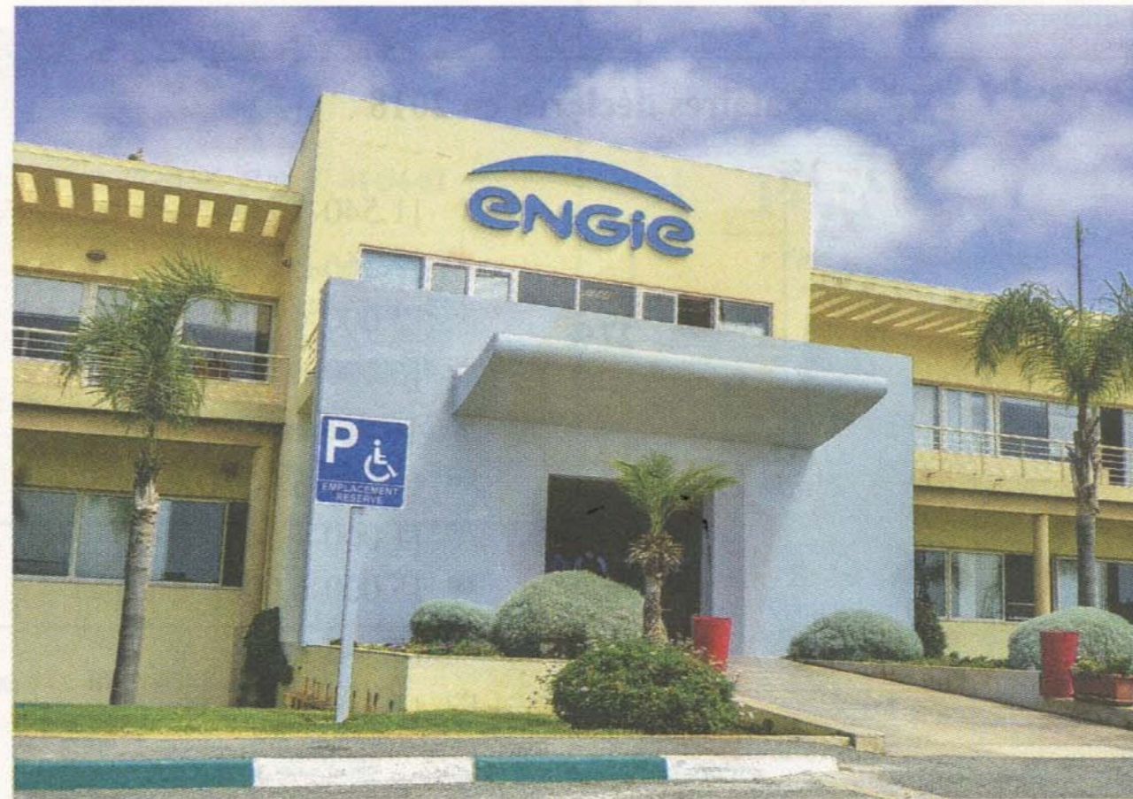
Grâce à l'expertise marocaine, Engie a été retenu pour l'exploitation et la maintenance du datacenter du groupement Orange Services à Abidjan, pour un contrat de cinq ans (Ph. F. Alnasser)
