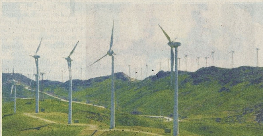
La première phase du parc de Taza est composée de 27 turbines éoliennes d'une puissance unitaire de 3,23 MW fabriquées par General Electric.
